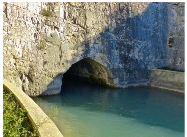
Sortie sud du tunnel du canal
