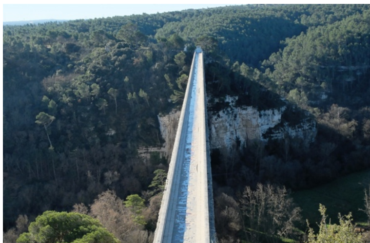
Au-dessus de l'aqueduc : le franchissement de la vallée de l'Arc
