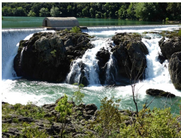
Le barrage sur l'Hérault
